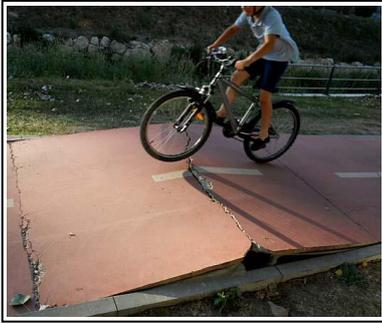
166. Como se aprecia en la foto la plancha de material por la que circula el ciclista, se ha dilatado mas que su soporte, y a consecuencia de este efecto ha perdido la horizontalidad, para evitar esto en la estructura con mezcla de materiales se hacen:
