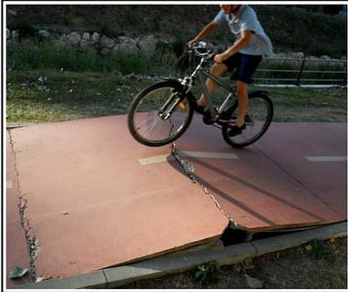
166. Como se aprecia en la foto la plancha de material por la que circula el ciclista, se ha dilatado mas que su soporte, y a consecuencia de este efecto ha perdido la horizontalidad, para evitar esto en la estructura con mezcla de materiales se hacen:
